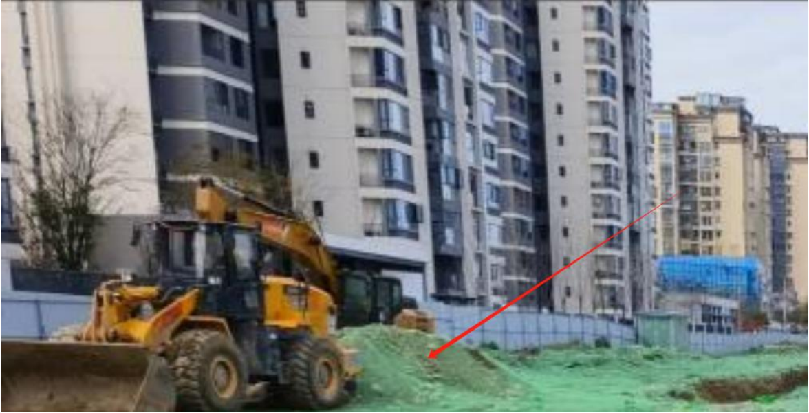
图2.2-2 临时表土放区照片
