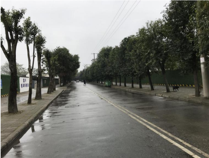
塘汛街道场镇群涪中路南段车行道现状
