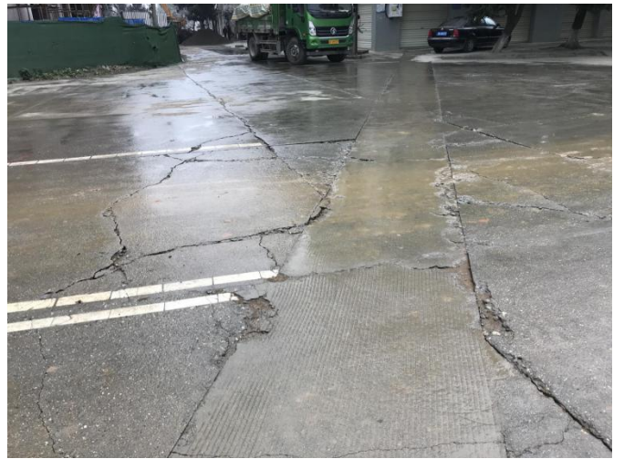
塘汛街道场镇塘汛街东段车行道现状
