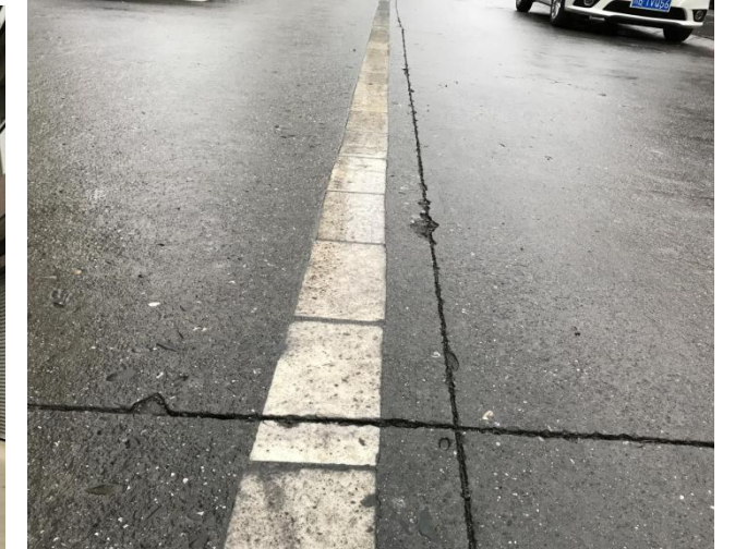
塘汛街道场镇廖家巷车行道现状
