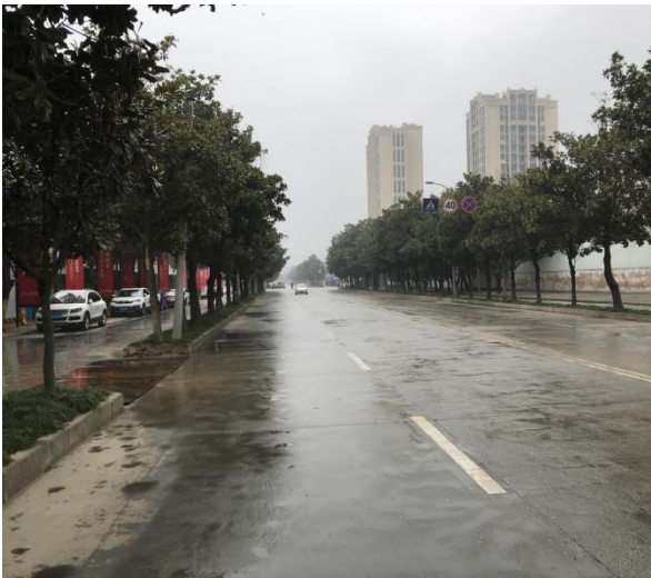
塘汛街道场镇塘汛街东段车行道现状
