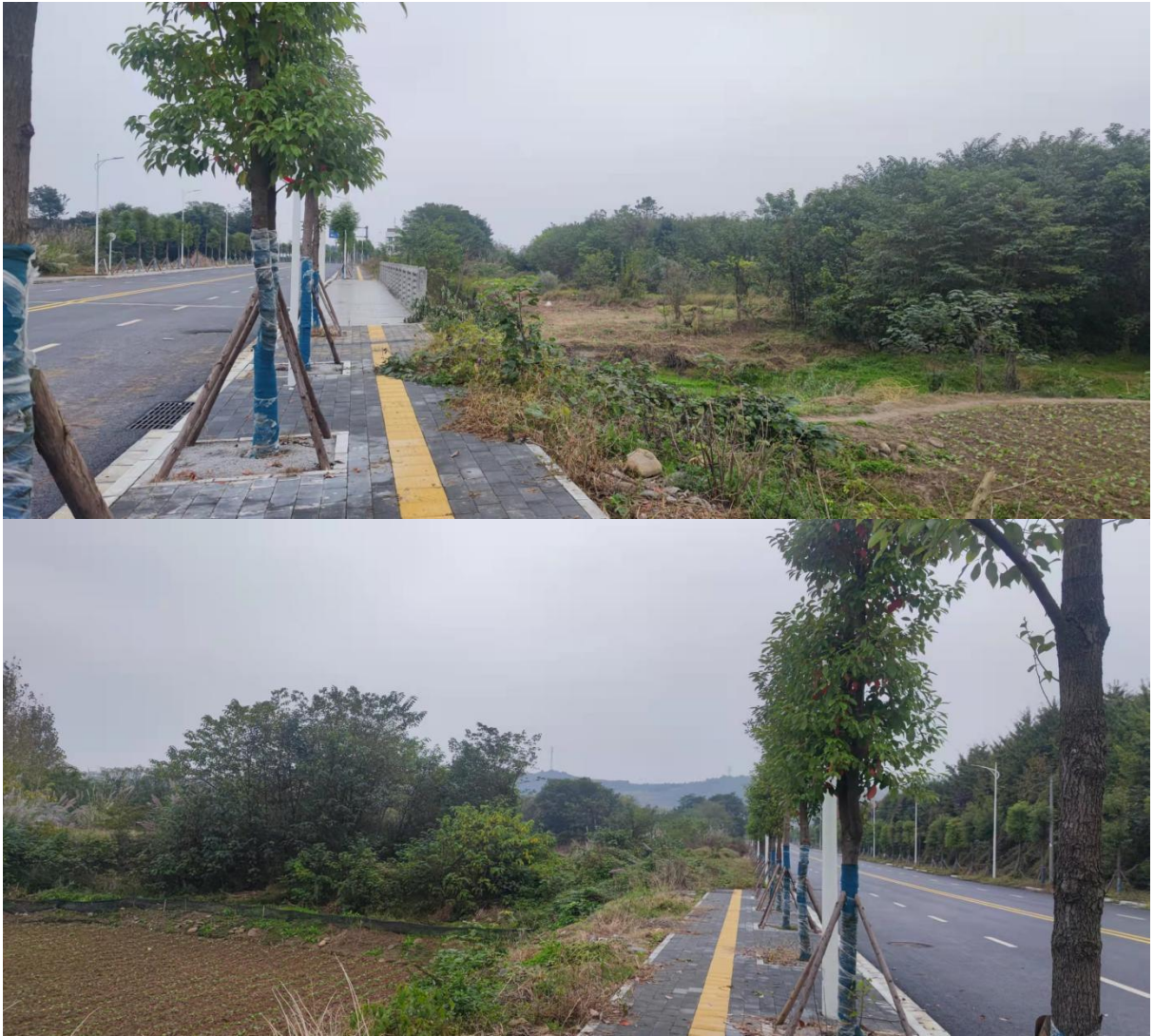
图 2.2-2 弃土场周边道路现状
