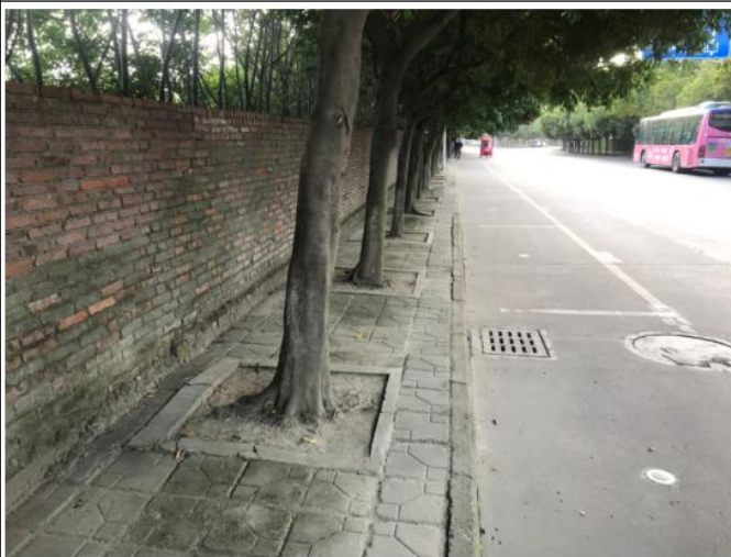
板桥街车行道现状
