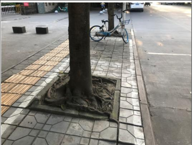
板桥街人行道现状
